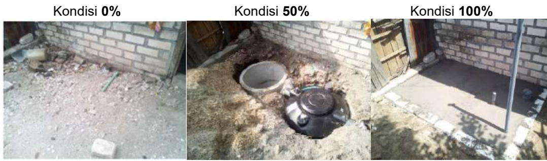
Gambar 3. 12 Pembangunan Spald-S Dak Bidang Sanitasi Desa Randuboto
