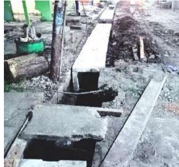
Gambar 3. 4 Foto Kegiatan Pembangunan Saluran / Drainase Lingkungan Permukiman Karangpoh Kecamatan Gresik
