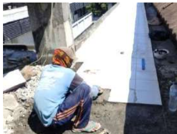
Gambar 3. 2 Foto Kegiatan Pembangunan Sarana dan Prasarana Rusunawa Proses Pemasangan keramik di Rusunawa Sawo
